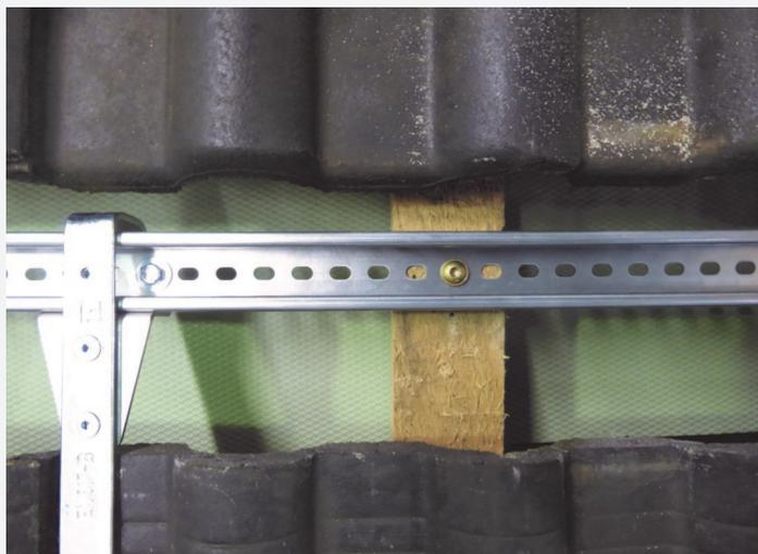
Montage der C-Profilschiene zwischen vorhandene Traglattung.
