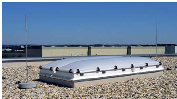
Bild 1.1.1.17 Schutz kleinerer Dachaufbauten vor Direkteinschlägen mit Fangstangen
