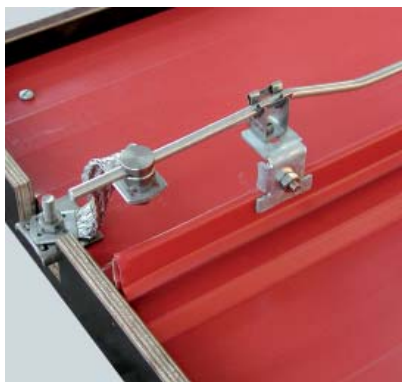
Bild 1.1.4.6 Musteraufbau Stefalz-Dach
