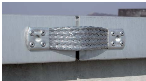
Bild 1.1.3.3 Attika-Überbrückung
