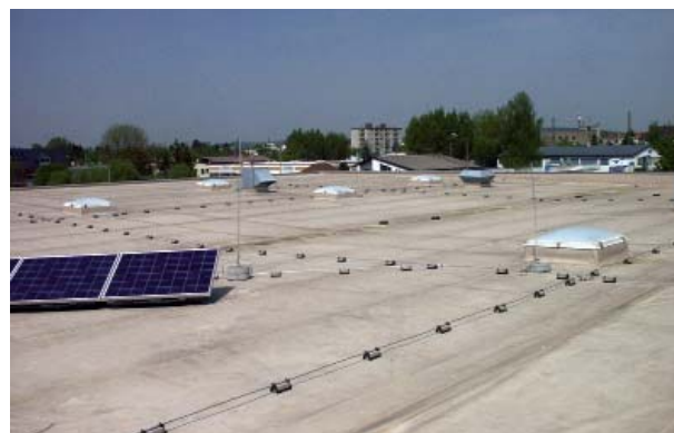
Bild 1.1.3.2 Anwendung Fangstangen
