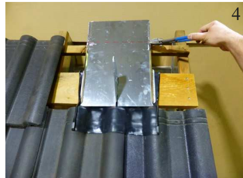
Abdeckblech bis Oberkante Traglattung kürzen...
