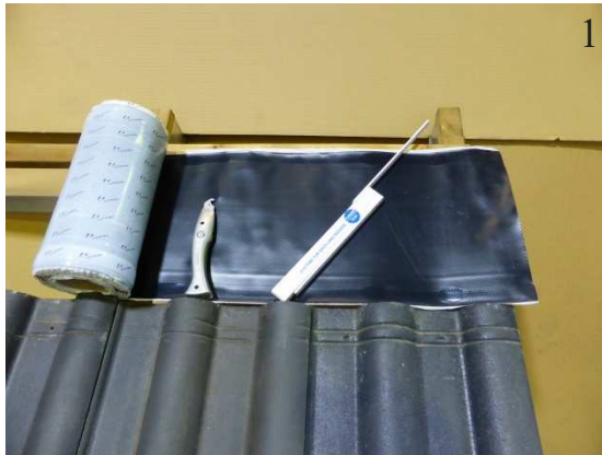
Ca. 35 cm Dichtband ablängen
