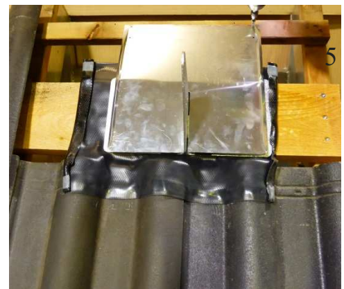
...und mit Nägeln an dieser befestigen
