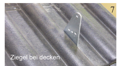
Deckelement + ca. 1cm im Bereich des Schwer-tes aussparen / schlitzen (Rasterunabhängig)
