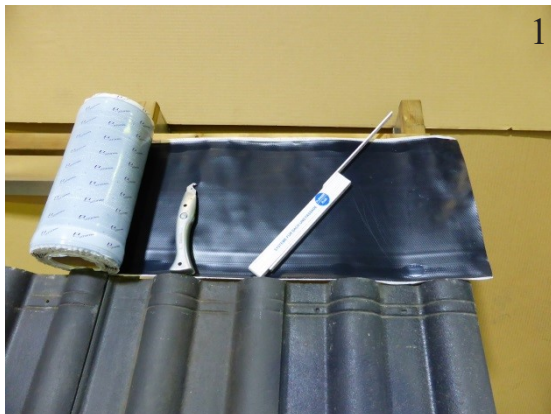
Ca. 35 cm Dichtband ablängen
