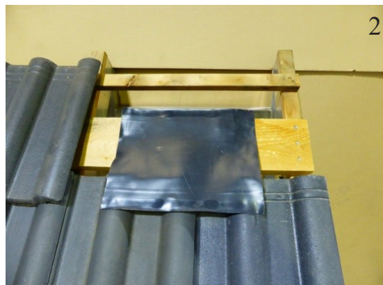
Dichtband mit nötiger Überdeckung über Ziegel und Bohle legen. (Dachdurchführung ist Rasterunabhängig)
