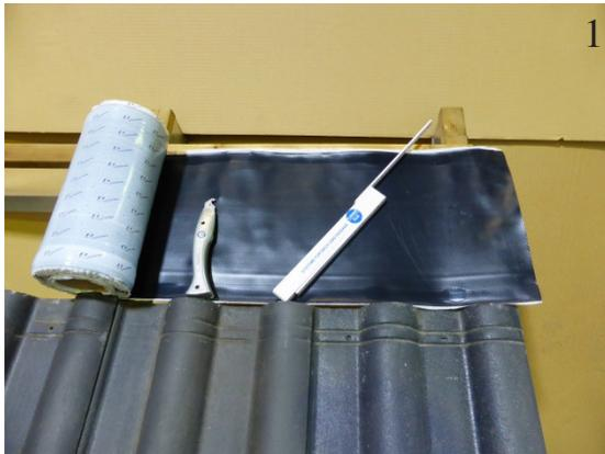
Ca. 35 cm Dichtband ablängen
