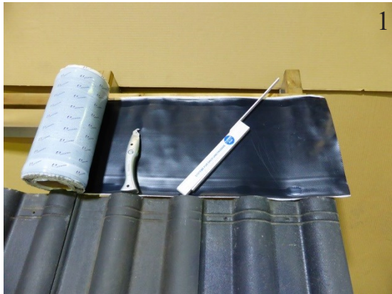
Ca. 35 cm Dichtband ablängen
