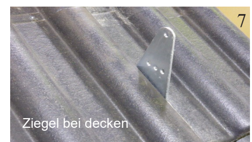
Deckelement + ca. 1cm im Bereich des Schwer- tes aussparen / schlitten (Rasterunabhängig)
