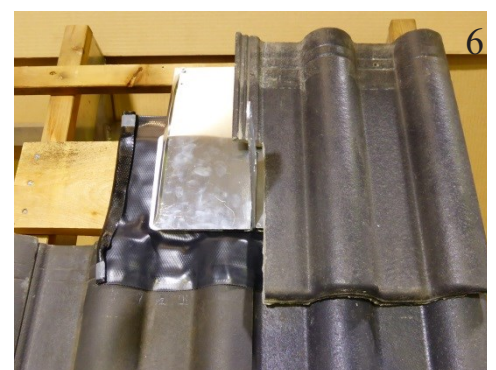
Deckelement + ca. 1cm im Bereich des Schwer- tes aussparen / schlitten (Rasterunabhängig)
