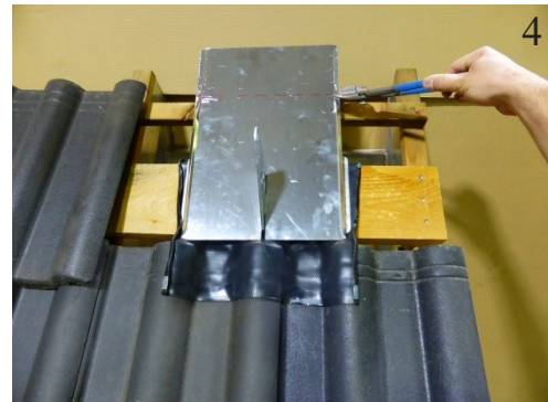
Abdeckblech bis Oberkante Traglattung kürzen...
