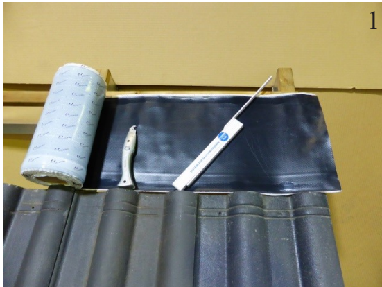
Ca. 35 cm Dichtband ablängen
