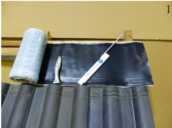
Ca. 35 cm Dichtband ablängen.
