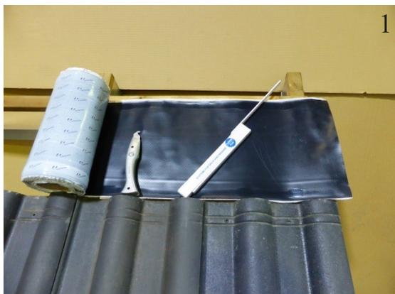
Ca. 35 cm Dichtband ablängen
